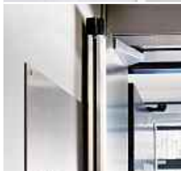
Alignement exact avec la porte palière
